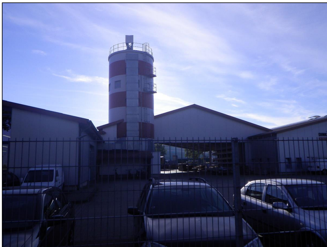
Abbildung 5: Im nördlichen Plangebietsteil befindet sich das Betriebsgelände eines holzverarbeitenden Betriebes (Oktober 2018).
