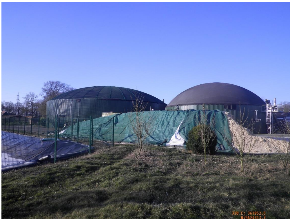
Foto 1: Blick auf die vorhandene Biogasanlage im Teilgeltungsbereich 5.1 und ihr näheres Umfeld.
