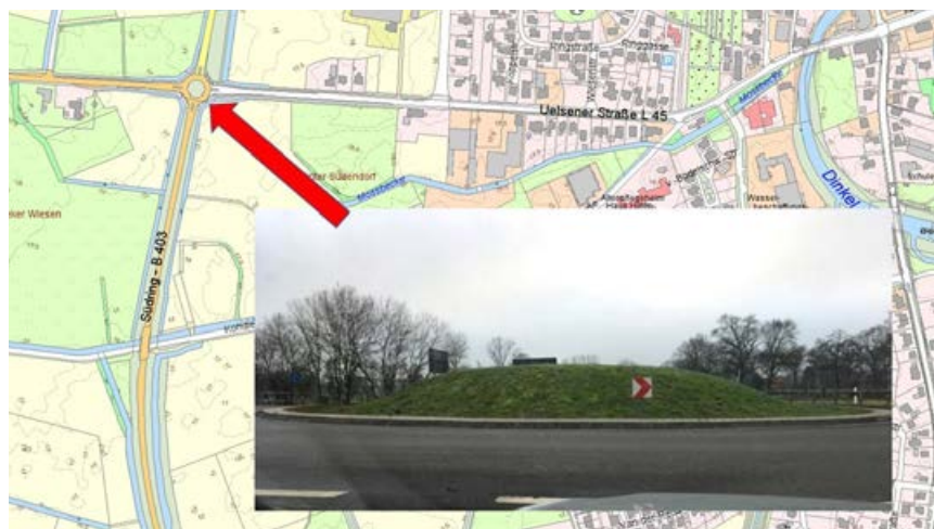
Abb. 78: Kreisverkehr - Umgehungsstraße B403 - im Ortsteil Hiltens
