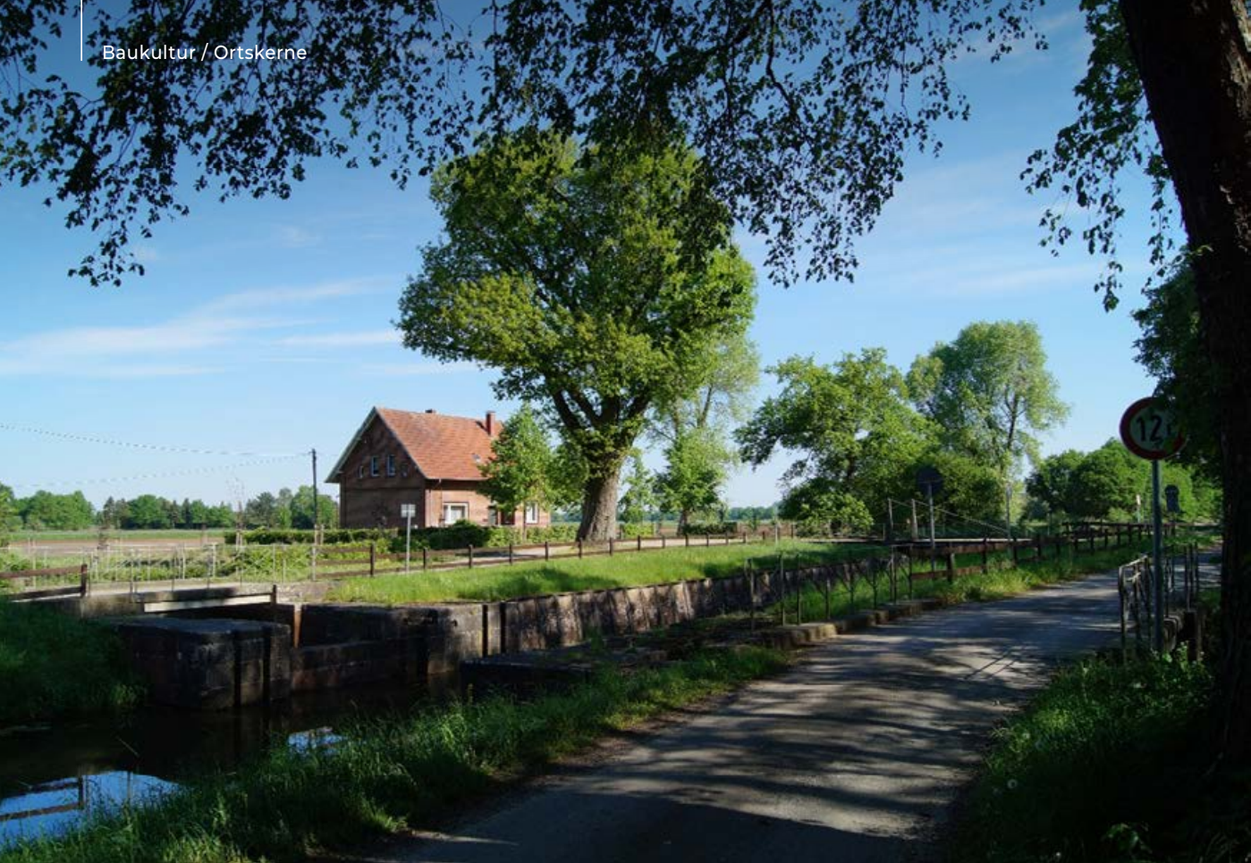
Abb. 20: Koppelschleuse am Ems-Vechte-Kanal
