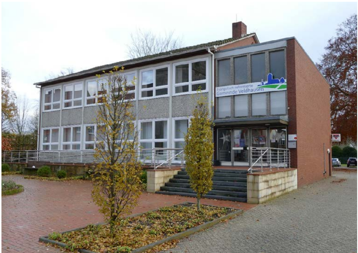
Abb. 58: Ev. - ref. Gemeindehaus in Veldhausen
