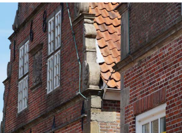
Abb. 22: Aufwendige Giebel zieren viele Häuser in Neuenhaus und Veldhausen
