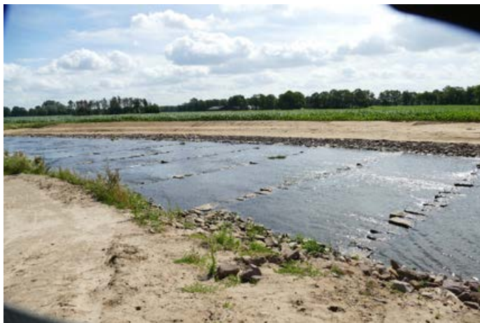
Abb. 86: Neu erstellte Sohlgleite am alten Wehr War / Dinkel
