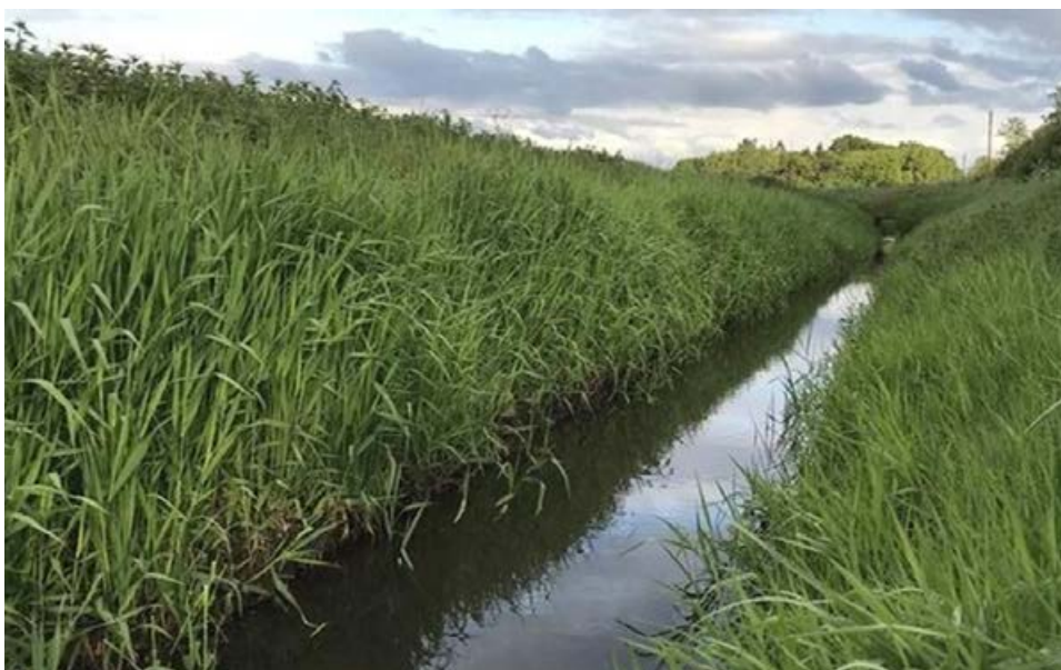
Abb. 68: Graben, derzeit ausschließlich mit Entwässerungsfunktion
